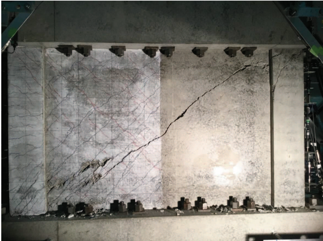
図 2-14 試験体 S-06-DIII 最終破壊時写真
