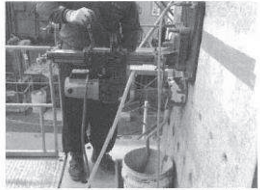
コンクリートコアドリルによる拡幅削孔
