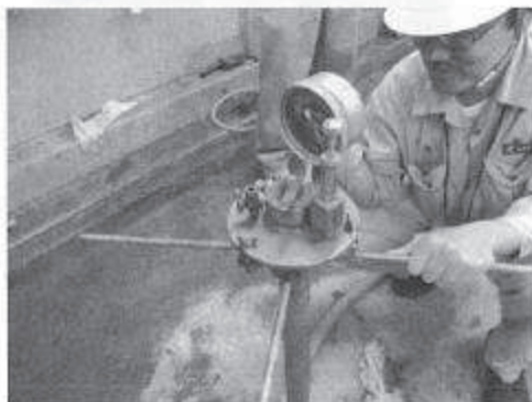
CCb 工法仕様上向き空気量測定
