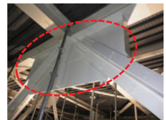
屋根トラス接合部の補強状況写真
