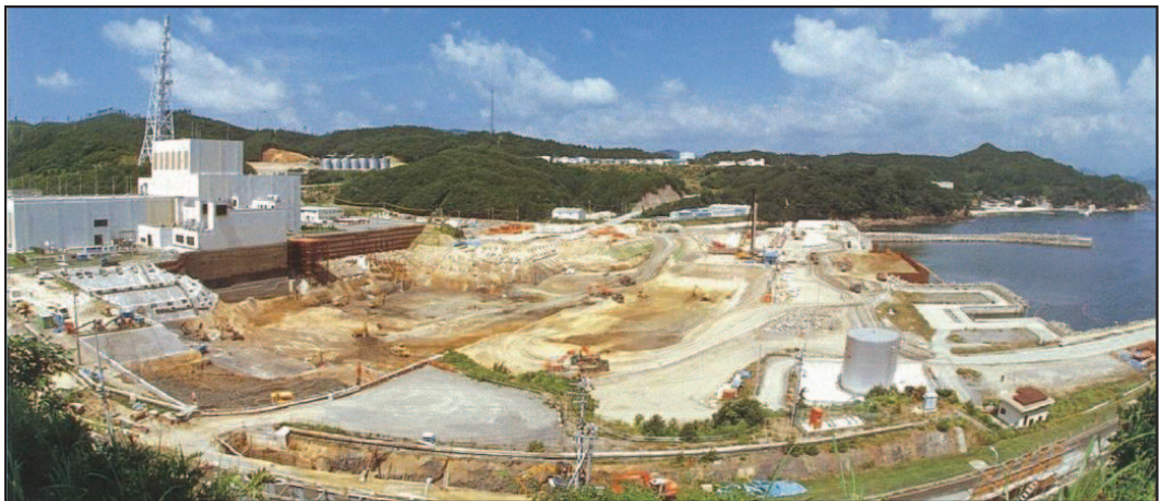
図 3-5 第 2 号機建設時の掘削状況
