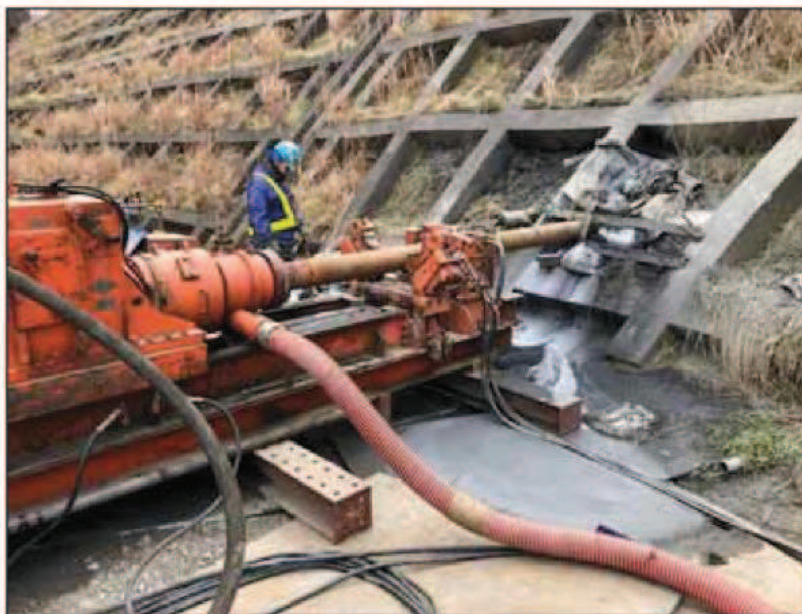
図8-4 (1) ドレーン（鋼管）試験施工状況
