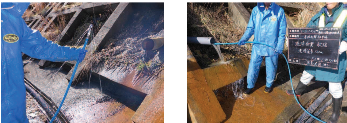
図 9-7 洗浄工（鋼管）の実施状況
