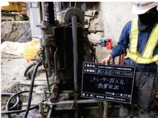
(a) 投入孔設置状況 (塩ビ管挿入)
