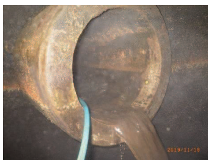
図 9-13 ヒューム管洗浄状況
