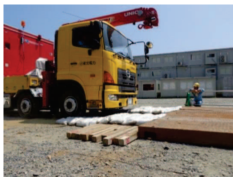
大型車両通行状況
