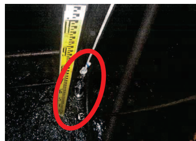
3号機水位計の例（揚水井戸⑦）
