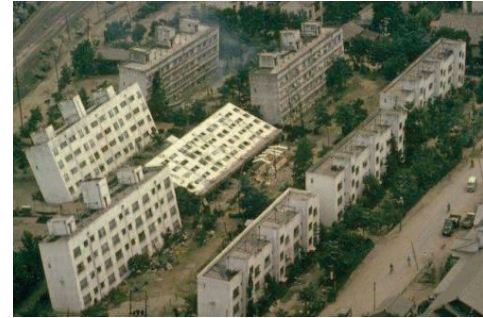
新潟地震で地盤の液状化現象により支持力を失って傾いた県営アパート*
