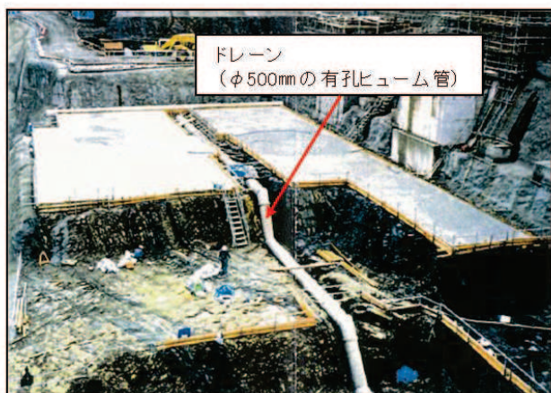
図 1-1-3 (2) 建屋等の直下のヒューム管設置状況 (タービン建屋直下の φ 500 ヒューム管の例)
