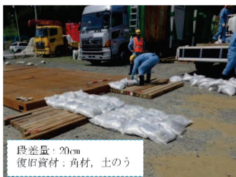
段差復旧作業状況
