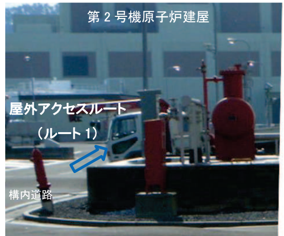
写真 C:地震後の状況【平成 23 年 3 月 12 日撮影】
