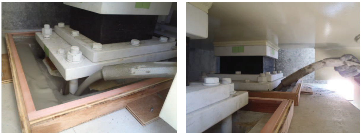
(無収縮モルタル施工状況の例)
