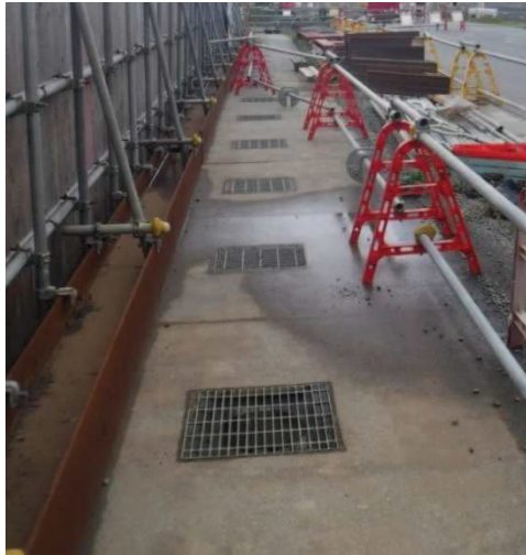
北側幹排水路（写真1）
