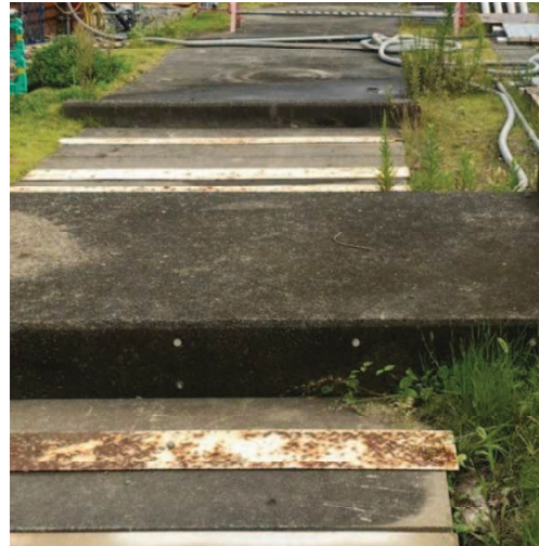
南側幹線排水路（写真2）
