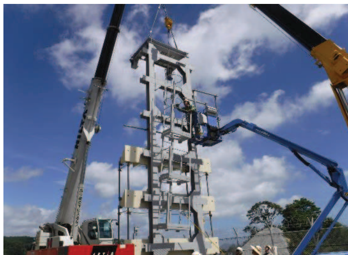
写真 10.4-2 吊治具の立起こし状況
