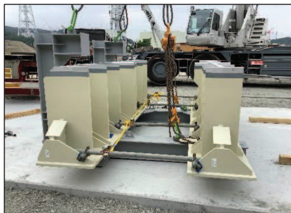
吊治具と架台の固定状況（最上段）
