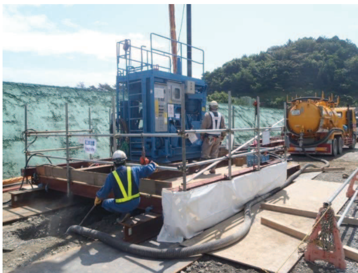
図 6.4-3 施工状況写真
