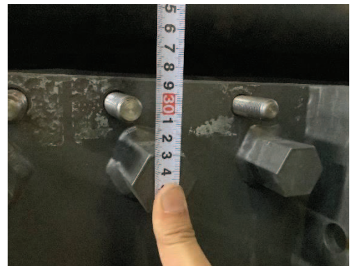
図 6.1.5-12(3) ゴムジョイント設置状況 (枠間距離計測)
