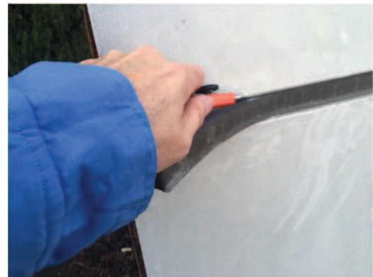
シリコーン材の切り取り状況
