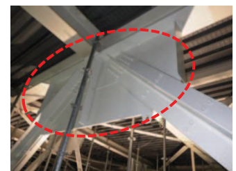
屋根トラス接合部の補強状況写真
