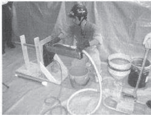
グラウトの充てん状況
