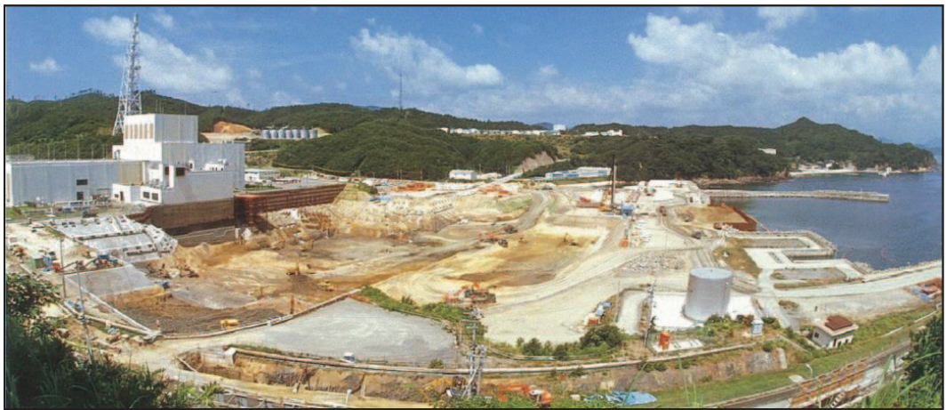
図 3-5 第 2 号機建設時の掘削状況
