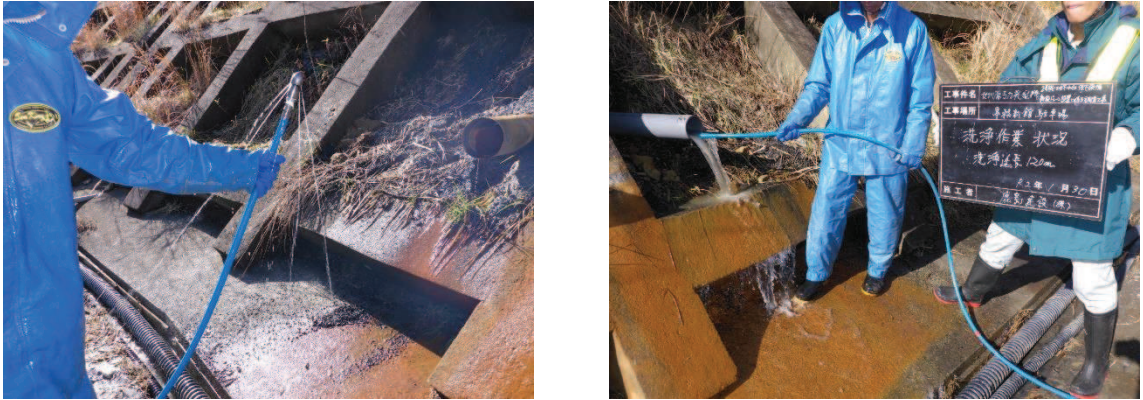
図 9-7 洗浄工（鋼管）の実施状況
