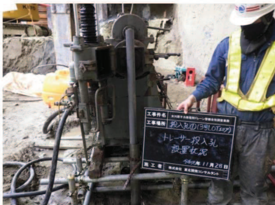
(a) 投入孔設置状況 (塩ビ管挿入)
