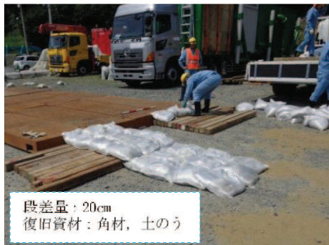
段差復旧作業状況
