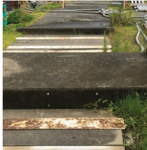
南側幹線排水路（写真2）
