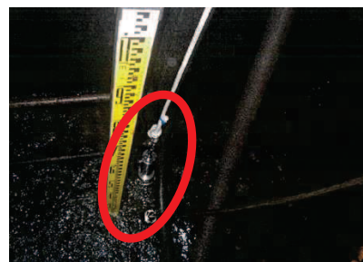
3号機水位計の例（揚水井戸⑦）
