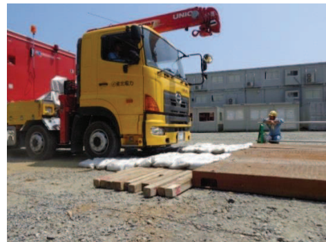
大型車両通行状況
