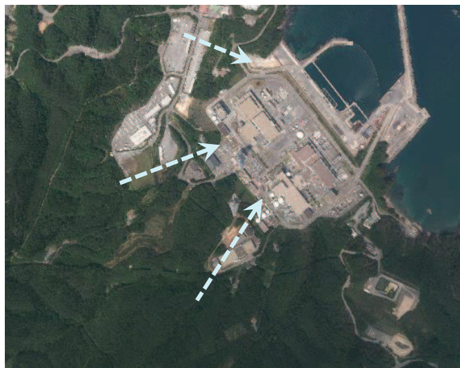
発電所周辺の空中写真(2011年撮影) (CTO20117 C28 23) 出典: 国土地理院
