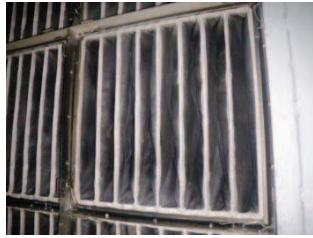
(バグフィルタ入口側)
