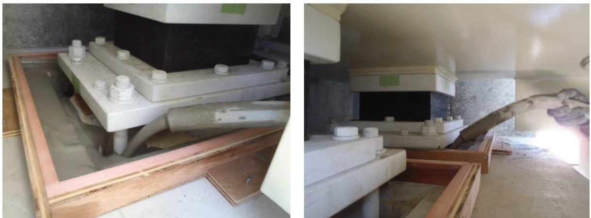
(無収縮モルタル施工状況の例)
