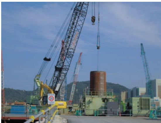
(オールケーシング工法による掘削)
