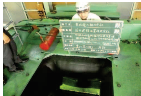
加圧完了 (0.15 MPa, 1 時間保持後, 漏水なし)
