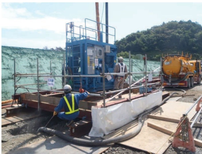
図 6.4-3 施工状況写真
