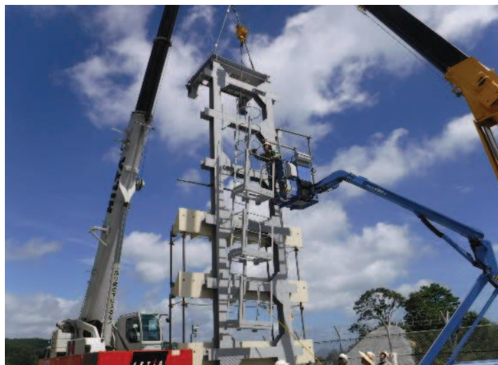
写真 10.4-2 吊治具の立起こし状況
