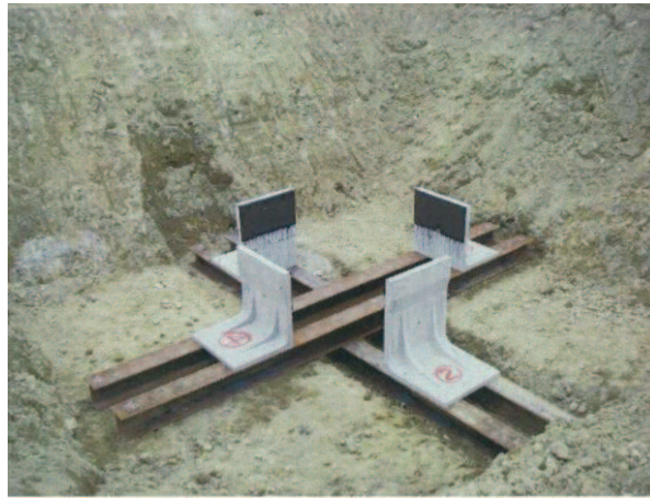
図 6.4-16 L字擁壁設置状況
