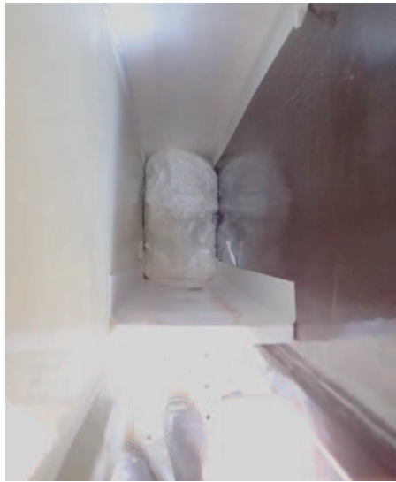
図3 目地内部でのウレタンの発泡状況
