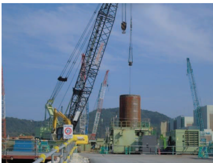
図 13.2-2 防潮堤（鋼管式鉛直壁）の鋼管杭施工写真
