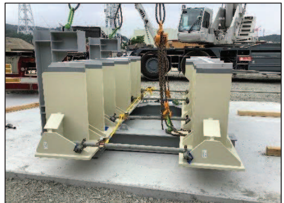
吊治具と架台の固定状況（最上段）
