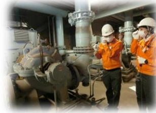
火力発電所での現地研修
