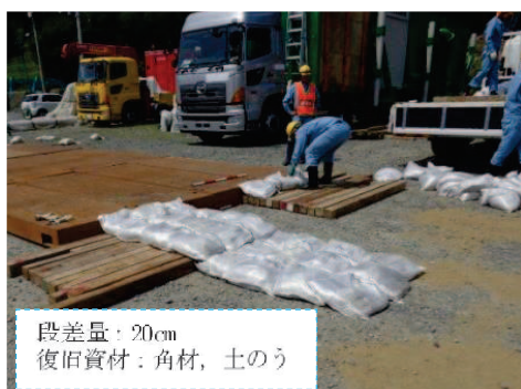
段差復旧作業状況
