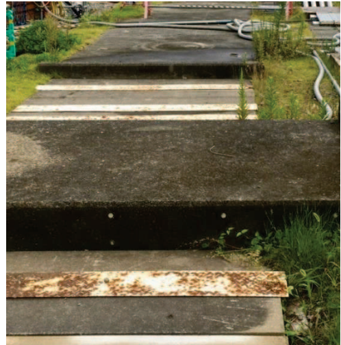
南側幹線排水路（写真2）
