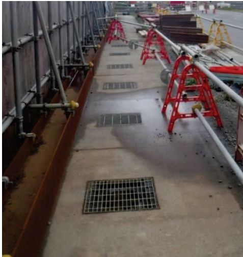
北側幹線排水路（写真1）
