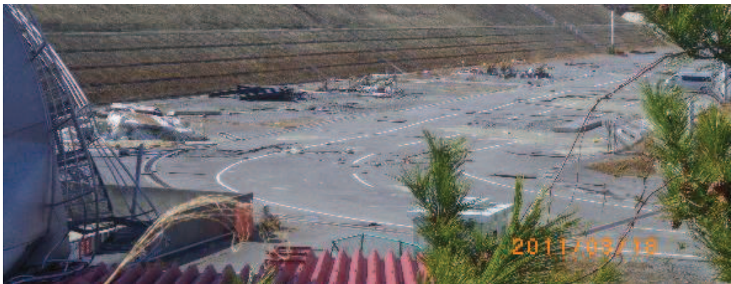
写真 6.5.1.8-1 敷地内で確認された東北地方太平洋沖地震に伴う津波の漂流物 （岸壁全体の漂流物状況（平成 23 年 3 月 18 日撮影））
