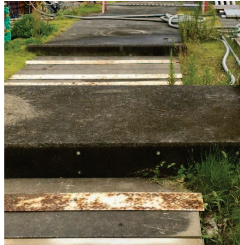
南側幹線排水路（写真2）
