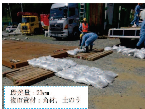
段差復旧作業状況
