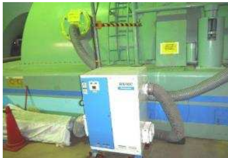
【タービン乾燥保管状況】
