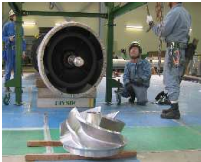
【海水ポンプ分解点検状況】
