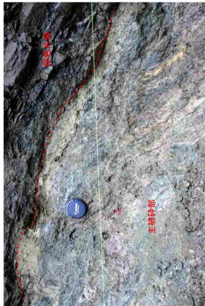
主破砕部南側境界付近の破砕部の状況
