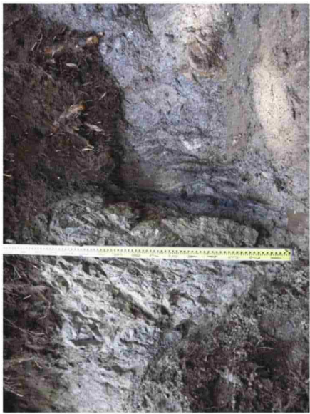
写真1 断層部の全景
