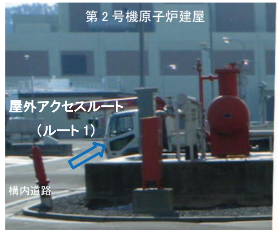
写真 C:地震後の状況【平成 23 年 3 月 12 日撮影】
