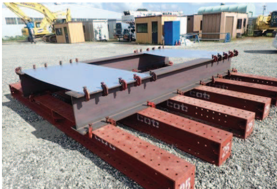
写真1 模擬屋根設置
