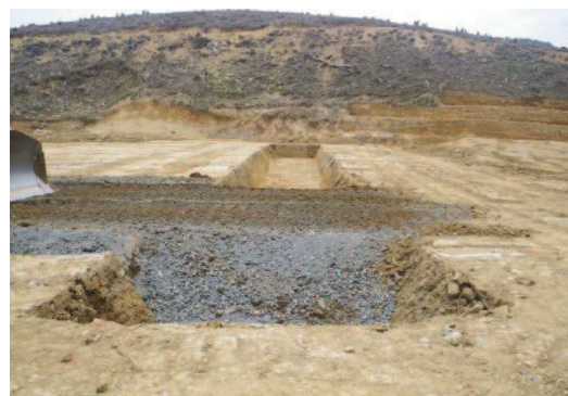
写真4 作業完了状況
