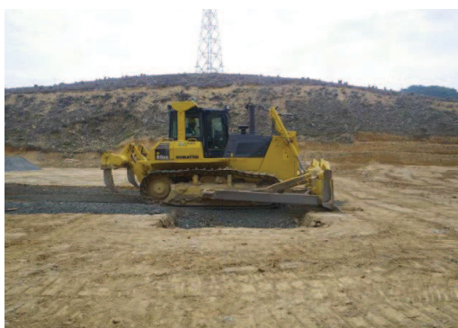
写真3 碎石運搬・埋め戻し・転圧状況
