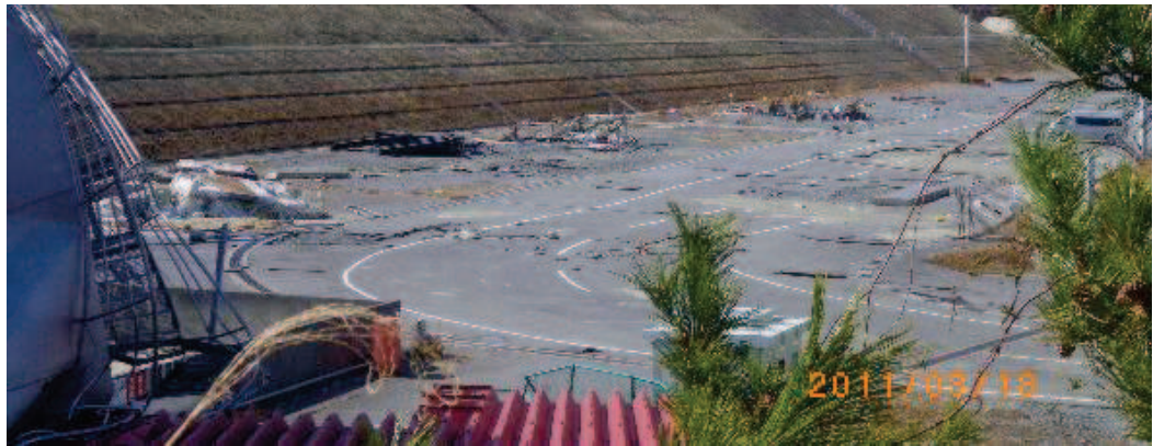
写真 3-1 敷地内で確認された東北地方太平洋沖地震に伴う津波の漂流物 (岸壁全体の漂流物状況 (平成 23 年 3 月 18 日撮影)) 【写真 4.2-1(2)を再掲】
