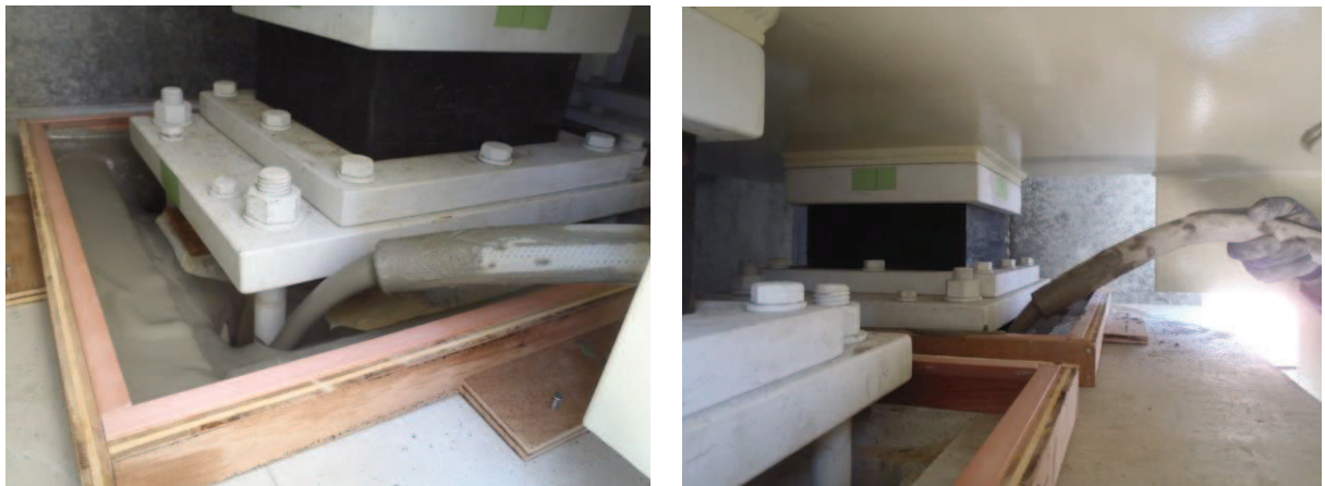
(無収縮モルタル施工状況の例)
