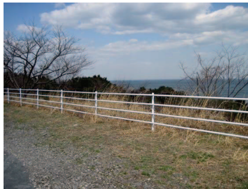
状況写真①
