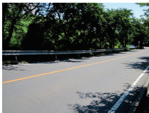
状況写真①
