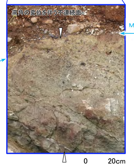
高角の変位を伴う不連続面c • 走向・傾斜:N46° E, 84° N • M 3 面段丘堆積物に変位・変形を与えていない。
