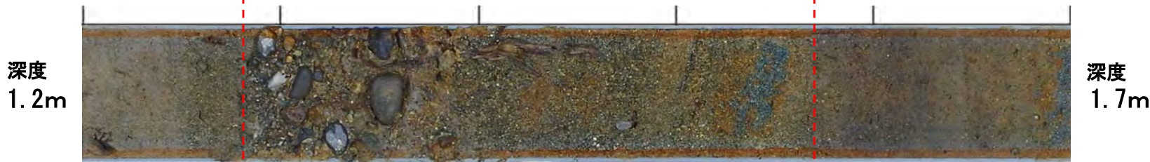
ボーリングコア写真
