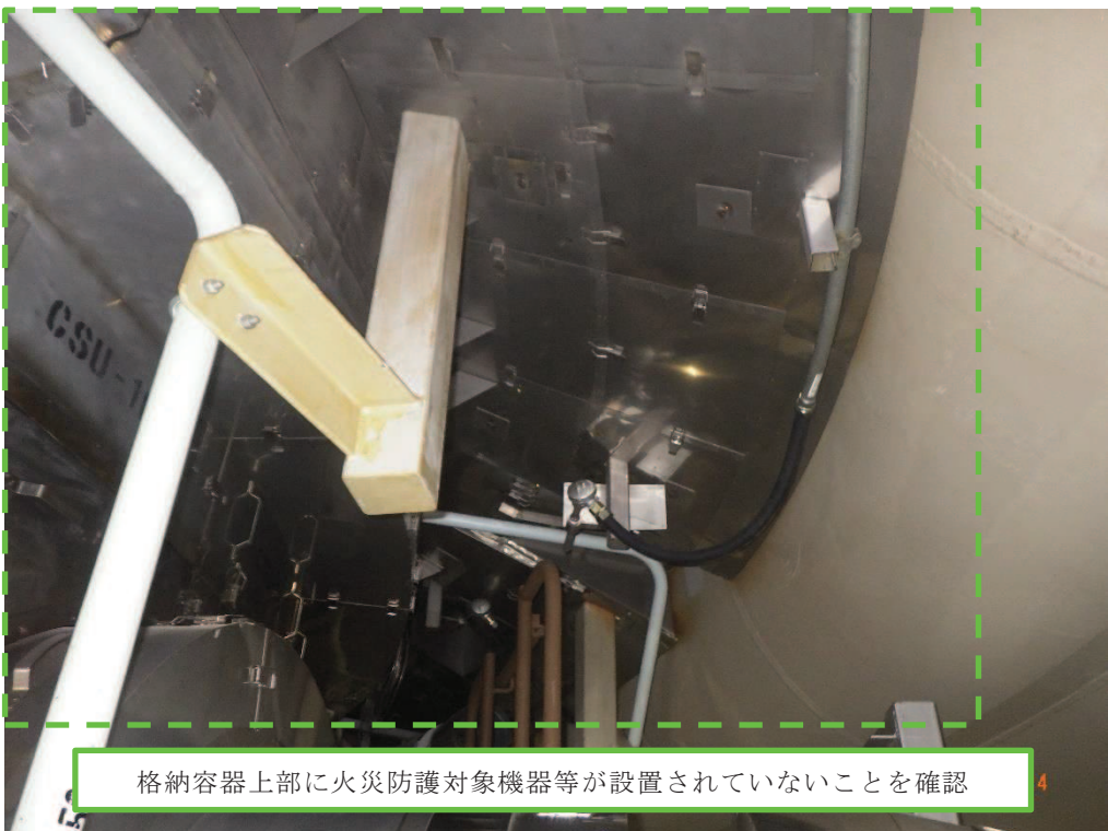
図8 原子炉格納容器上部
