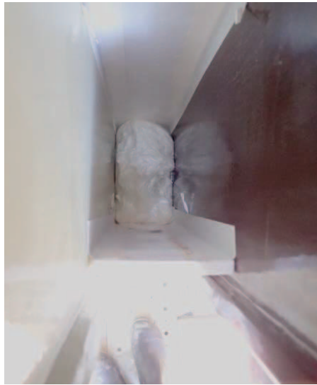
図3 目地内部でのウレタンの発泡状況
