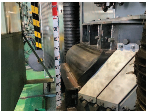
加圧状況 (漏えい無し)
