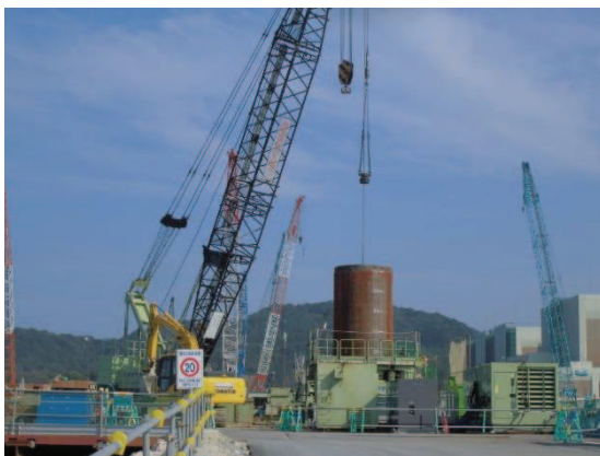
(オールケーシング工法による掘削)
