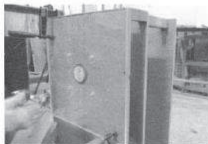
「セラミックキャップバー (CCb)」の設置
