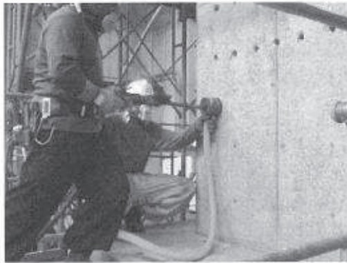
レッグハンマーによる削孔
