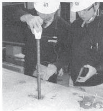
「セラミックキャップバー (CCb)」の挿入
