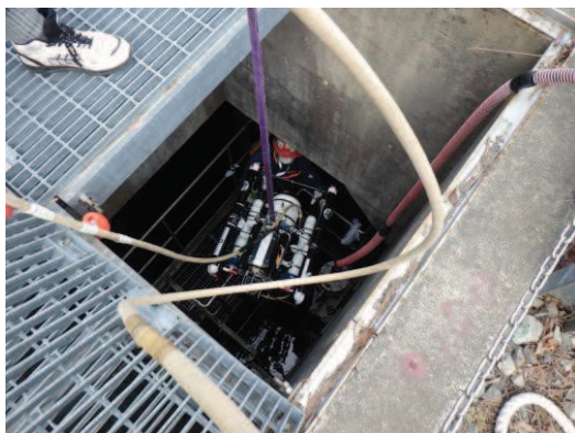
水中カメラを放水路内に投入
