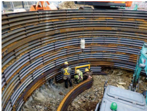
土砂部ライナープレート取付け
