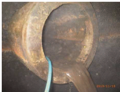
図9-13 ヒューム管洗浄状況
