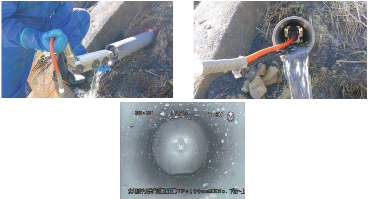
図 9-6 カメラ調査（鋼管）の実施状況
