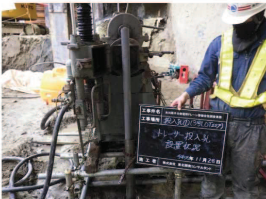
(a) 投入孔設置状況（塩ビ管挿入）
