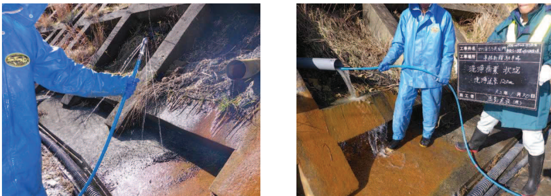
図 9-7 洗浄工（鋼管）の実施状況
