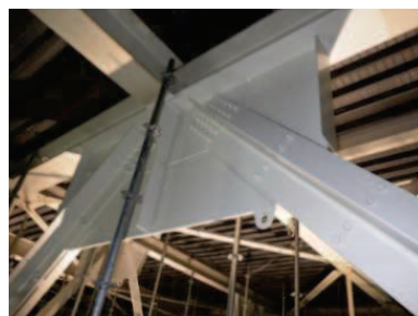
主トラス接合部の補強例
