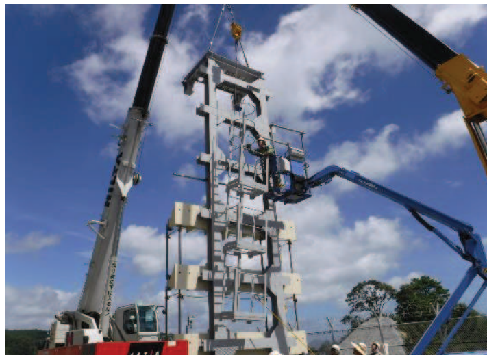
写真 4-2 吊治具の立起こし状況
