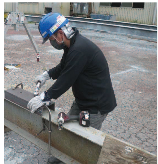
M16 締付状況写真 (トルクレンチ使用時)
