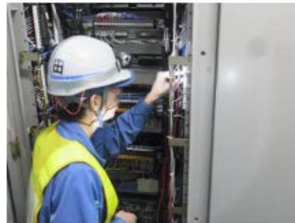
可搬型計測器の接続 原子炉補助建屋（T.P. 17.8m）
