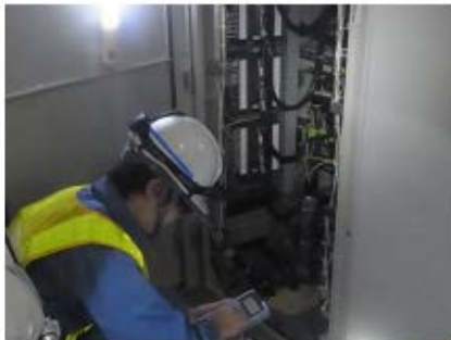
可搬型計測器の接続 原子炉補助建屋（T.P. 17.8m）
