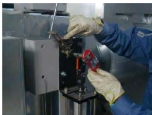
(空気作動ダンパ開作業イメージ)
