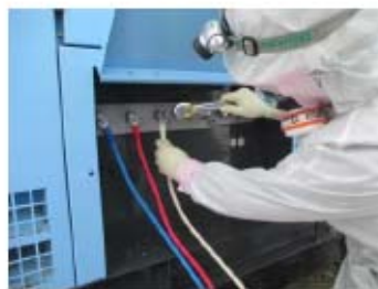
可搬型直流電源用発電機ケーブル接続 (屋外 T.P. 31m)
