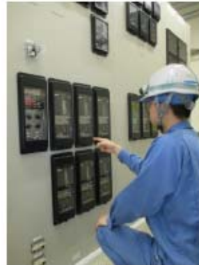
保護リレーロック操作 (1号機 2次系継電器室) (原子炉建屋 T.P. 10.3m)
