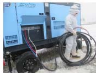
可搬型直流電源用発電機ケーブル敷設 (屋外 T.P. 31m)
