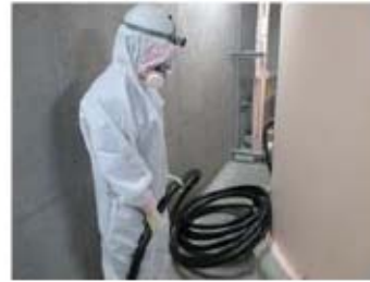
燃料汲み上げ用ホース接続及び敷設 (ディーゼル発電機燃料油サービスタンク室) (原子炉建屋T. P. 17. 8m)
