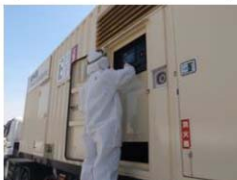
可搬型代替電源車起動 (屋外T. P. 31m)
