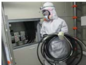
可搬型直流変換器 直流出力ケーブル敷設作業 (安全補機開閉器室) (原子炉補助建屋 T.P. 10.3m)
