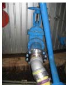
ろ過水タンクからの補給（屋外 T.P. 10m）
