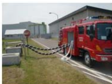
可搬型大型送水ポンプ車の設置 原水槽への吸管挿入 (屋外 T. P. 10m)
