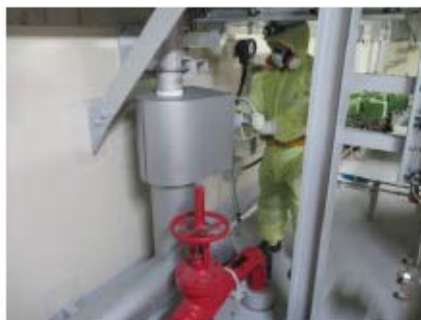
格納容器へのスプレイライン系統構成 （運転員（現場）①） （原子炉補助建屋 T.P. 14. 5m）
