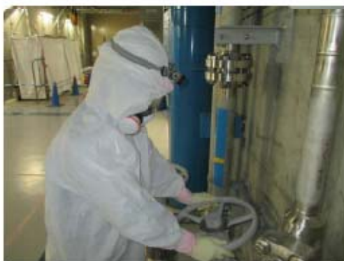
炉心注水から格納容器スプレイへの切り替え 系統構成 (原子炉建屋 T. P. 10. 3m)
