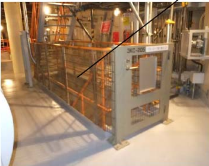
(写真B) 階段開口部に設置したパンチングメタル
