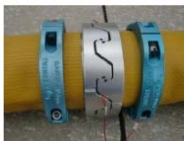
可搬型ホース(150A)接続後
