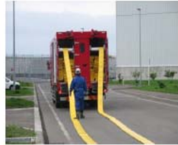
ホース延長・回収車による 可搬型ホース敷設 (屋外 T. P. 10m)
