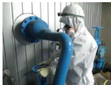
2次系純水タンクからの補給（屋外 T.P. 10m）
