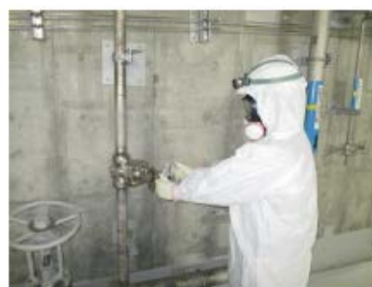
格納容器へのスプレイライン系統構成 （運転員（現場）②） （原子炉建屋 T.P. 10. 3m）
