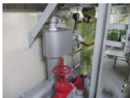
消火水注水系統構成 （運転員（現場）①） （原子炉補助建屋 T.P. 14. 3m）
