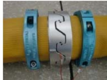
可搬型ホース(150A)接続後
