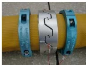
可搬型ホース (150A) 接続後
