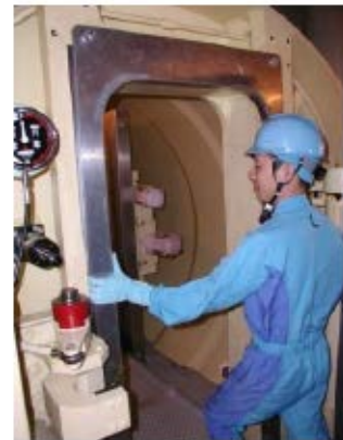
エアロック閉止準備 (格納容器 T.P. 24. 8m)
