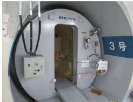
エアロック閉止前 (原子炉補助建屋 T.P. 24. 8m)
