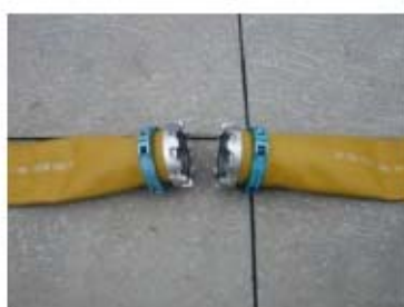
可搬型ホース (150A) 接続口
