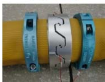
可搬型ホース (150A) 接続後
