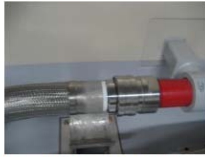
消火水系統と格納容器スプレイ系統の 接続のためフレキシブル配管接続後
