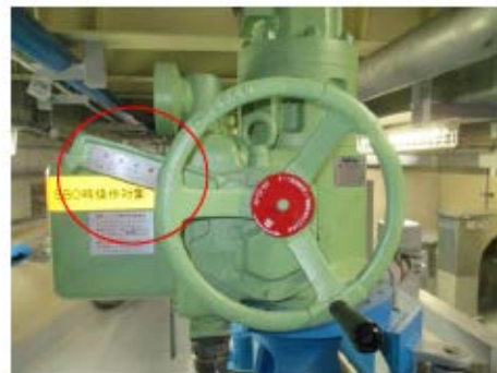
電動弁（手動操作レバー）
