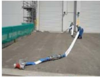
可搬型ホース敷設 (屋外 T. P. 31m)
