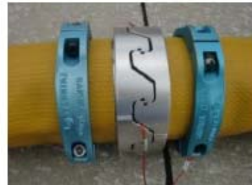
可搬型ホース (150A) 接続後
