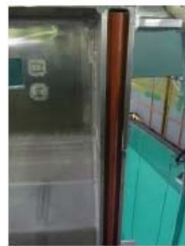
ゲートパッキンの装着状況
