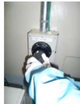
電源ケーブル接続
