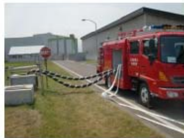
可搬型大型送水ポンプ車の設置 代替給水ピットへの吸管挿入 (屋外 T. P. 31m) (作業風景は類似作業)
