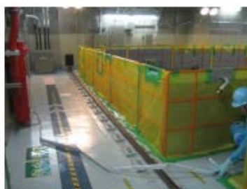
消防ホース敷設 (原子炉建屋 T.P. 33. 1m)
