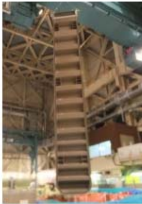
ゲート吊上げ作業 (写真は2号機)
