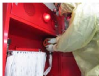
消火ポンプによる注水 (原子炉建屋 T.P. 33. 1m)
