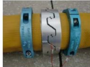
可搬型ホース (150A) 接続後
