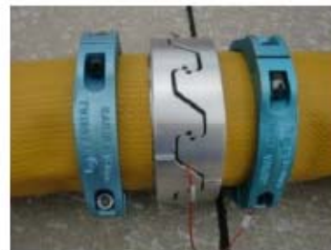
可搬型ホース (150A) 接続後
