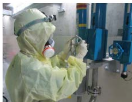
格納容器スプレイポンプ 自己冷却運転系統構成 (原子炉補助建屋 T.P. -1.7m)
