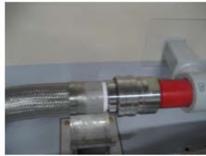
消火水系統と格納容器スプレイ系統の 接続のためフレキシブル配管接続後
