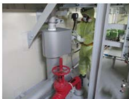
消火水注水系統構成 （運転員（現場）①） （原子炉補助建屋 T.P. 14. 3m）
