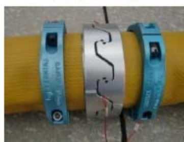
可搬型ホース (150A) 接続後
