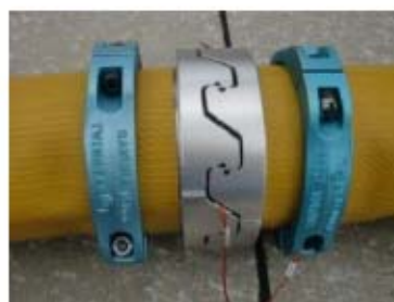
可搬型ホース(150A)接続後
