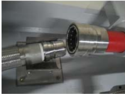
消火水系統と格納容器スプレイ系統の 接続のためフレキシブル配管接続口 (運転員(現場)①) (原子炉補助建屋 T.P. 10.3m)
