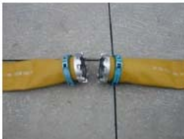
可搬型ホース (150A) 接続口
